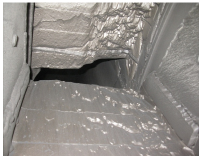
Szczelina na progu największa ok. 7,5 \div 14 cm
