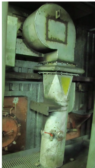
Rys. 10.2 Lokalizacja punktów poboru pyłu na poziomie 12 m przed palnikiem, widoczny palnik wirowy
