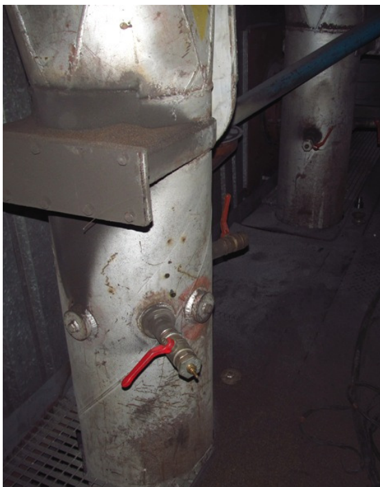
Rys. 10.2 Lokalizacja punktów poboru pyłu na poziomie 12 m przed palnikiem, widoczny palnik wirowy
